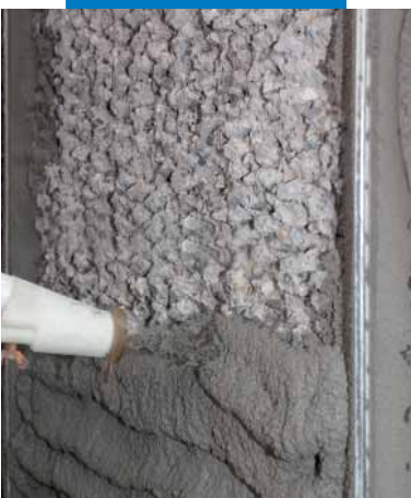
Nanoszenie Mapegrout z zastosowaniem metody natrysku
