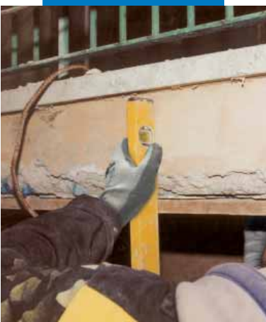
Naprawa gzymsów balkonowych: naprawa gzymsów balkonowych
