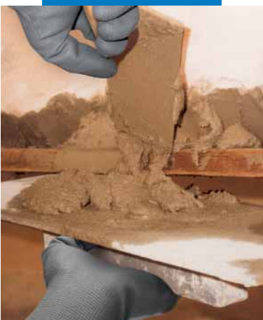
Naprawa gzymsów balkonowych: Nanoszenie Planitop 400
