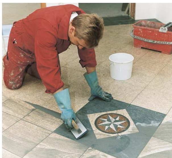
Fugi w okładzinach z kamionki szlachetnej o szerokości od 2 do 10 mm można wypełnić zaprawą PCI Megafug.
