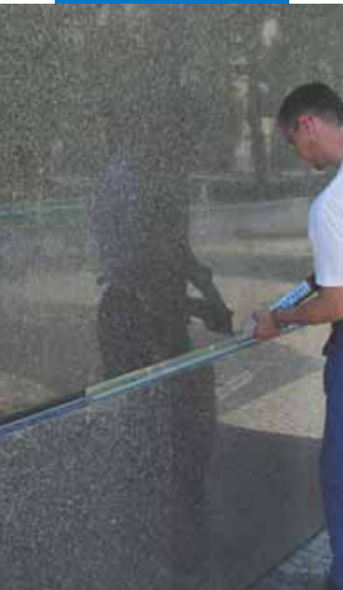
Uszczelnianie szczelin fasady za pomocą Mapesil LM
