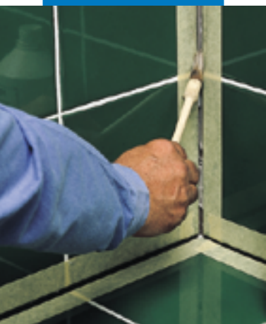
Gruntowanie boków szczeliny przy użyciu Primer FD
