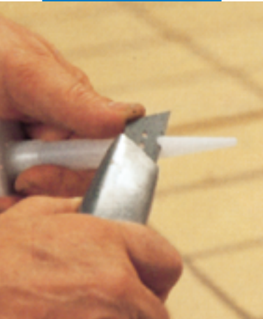
Przycinanie dyszy w zależności od przekroju szczeliny
