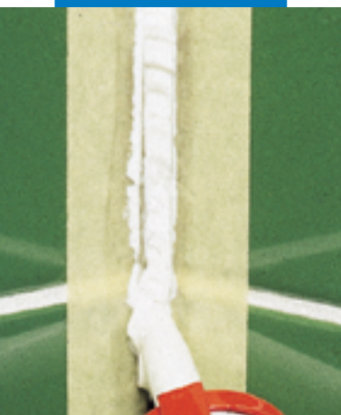
spoinowanie przy użyciu Mapesil AC
