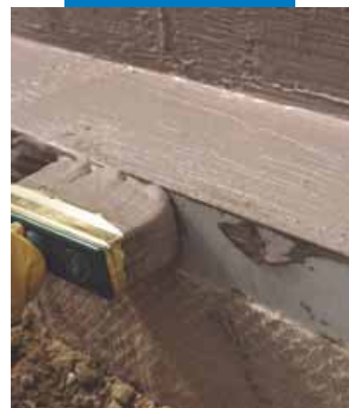
Uszczelnienie pionowej ściany przy użyciu Mapeproof i Mapeproof Smart
