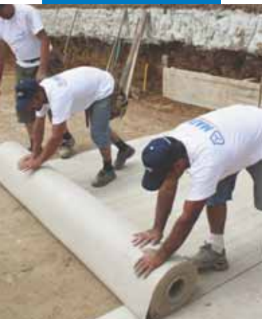
Przykład układania Mapeproof na powierzchni poziomej
