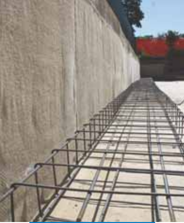
Układanie Mapeproof na membranie
