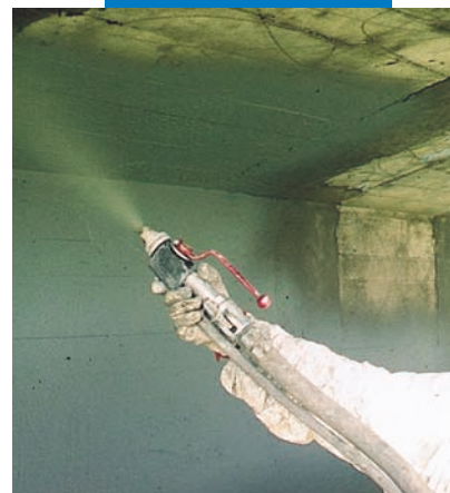
Przykład nanoszenia Mapelastic poprzez natrysk
