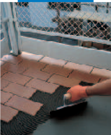
Montaż płytek na zaprawie klejowej Granirapid, na wcześniej wykonanej hydroizolacji Mapelastic
