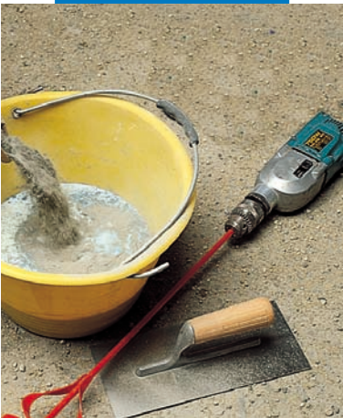
Mieszanie Mapelastic przy użyciu mieszadła mechanicznego
