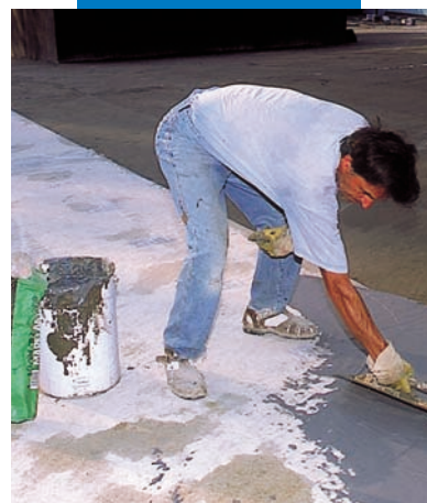
Wykonanie izolacji wodoszczelnej basenu przy użyciu Mapelastic
