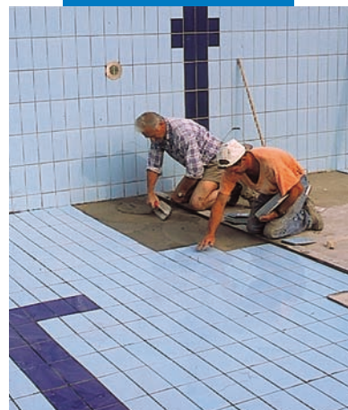
Mocowanie płytek ceramicznych na izolacji Mapelastic
