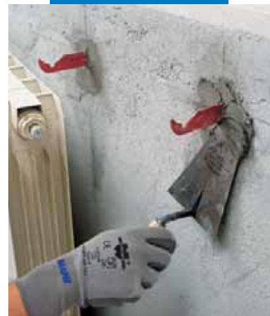
Mocowanie wieszaka kaloryfera z zastosowaniem Lampocem
