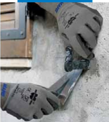
Zastosowanie Lampocem do mocowania śrub kotwiących okiennice
