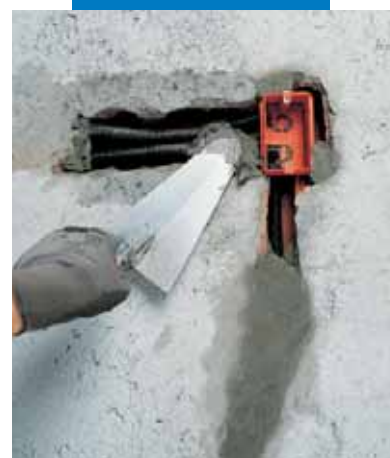
Mocowanie elementów instalacji elektrycznej z zastosowaniem Lampocem
