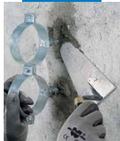
Montaż uchwyty do rur przy użyciu Lampocem
