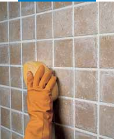
Czyszczenie płytek typu monocottura przy użyciu gąbki
