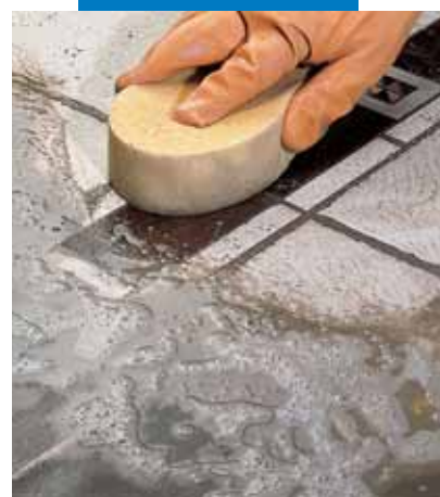
Oczyszczenie podłogi ceramicznej z elementami drewnianymi przy użyciu gąbki
