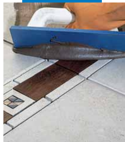
Spoinowanie przy użyciu pacy podłogi ceramicznej z elementami drewnianymi
