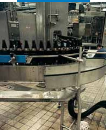
Przykład wykonanych spoin kwasoodpornych w browarze
