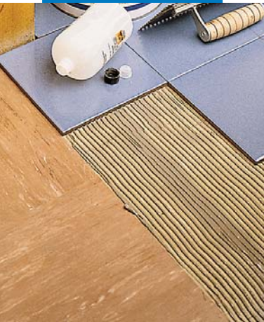
Nakładanie na stare podłoże z PVC
