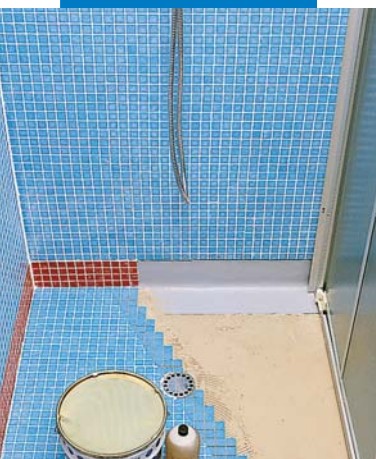
Uszczelnianie i nakładanie w prefabrykowanej kabinie prysznicowej
