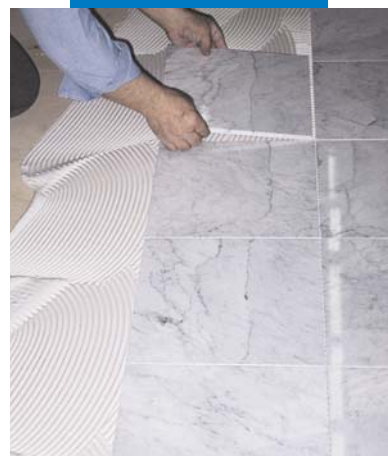
Układanie marmuru Carrara na drewnianym podłożu za pomocą Keralastic biały
