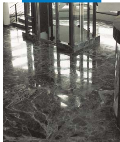
Podłoga z zielonego marmuru Alpi wykonana w holu budynku firmy Rolex (Bienne - Szwajcaria)
