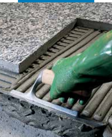
Montaż lastryko na zewnątrz
