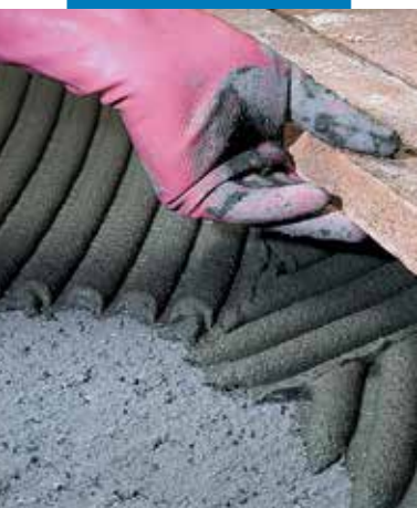
Układanie ręcznie wykonanej terakoty na nierównym podłożu
