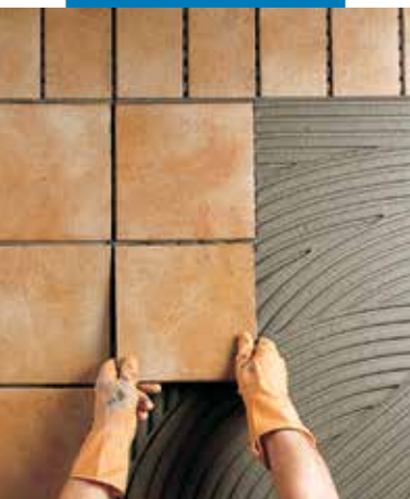
Montaż płytek klinkierowych na zewnątrz
