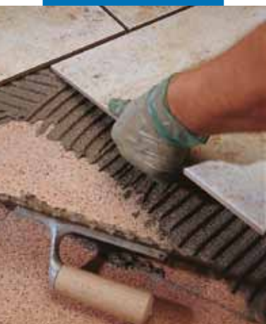
Montaż płytek na istniejące podłoże lastrykowe
