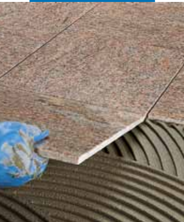
Układanie posadzki z marmuru polerowanego
