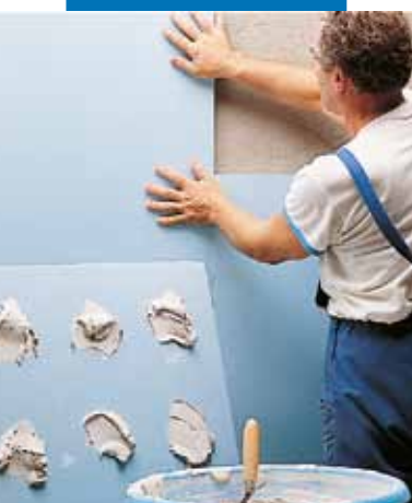
Montaż płyt styropianowych przy użyciu Keraflex białego
