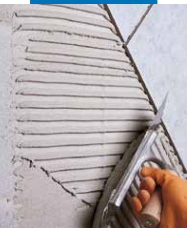
Montaż płytek typu monocottura na powierzchnię z bloczków z betonu komórkowego
