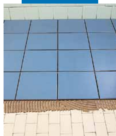
Montaż płytek ceramicznych na stare płytki przy użyciu Keraflex szary
