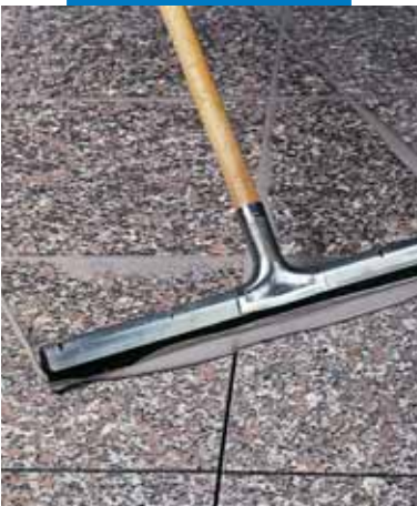
Fugowanie wyrównanego i wypolerowanego granitu gumową raklą
