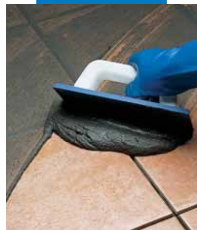
Fugowanie płytek przy użyciu gumowej pacy
