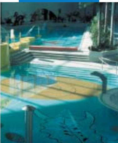
Montaż mozaiki i klinkieru w basenie
