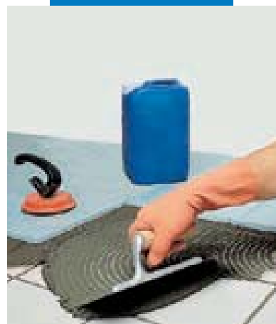
Montaż płytek na stare płytki ceramiczne przy użyciu szarej zaprawy klejowej Granirapid
