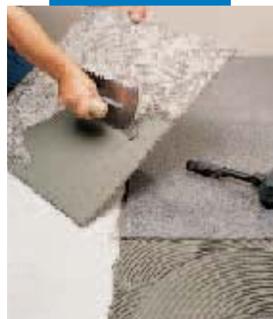
Montaż granitu syntetycznego przy użyciu szarej zaprawy klejowej Granirapid
