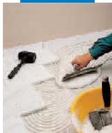
Montaż białego marmuru typu Carrara przy użyciu białej zaprawy klejowej Granirapid
