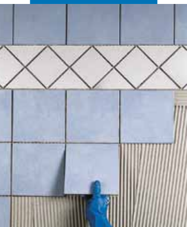
Montaż płytek typu monocottura na ścianie otynkowanej w łazience
