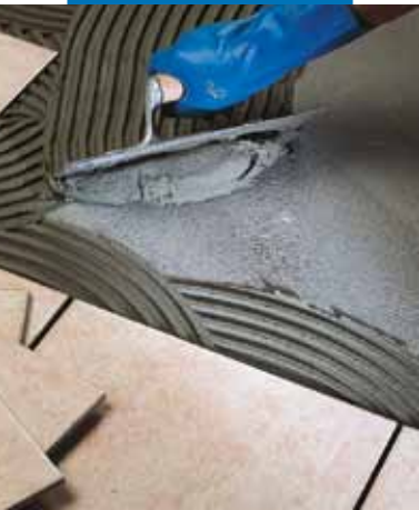
Montaż płytek typu monocottura na podłozie
