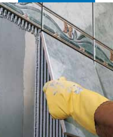
Montaż płytek typu monocottura na ścianie z płyty kartonowo-gipsowej
