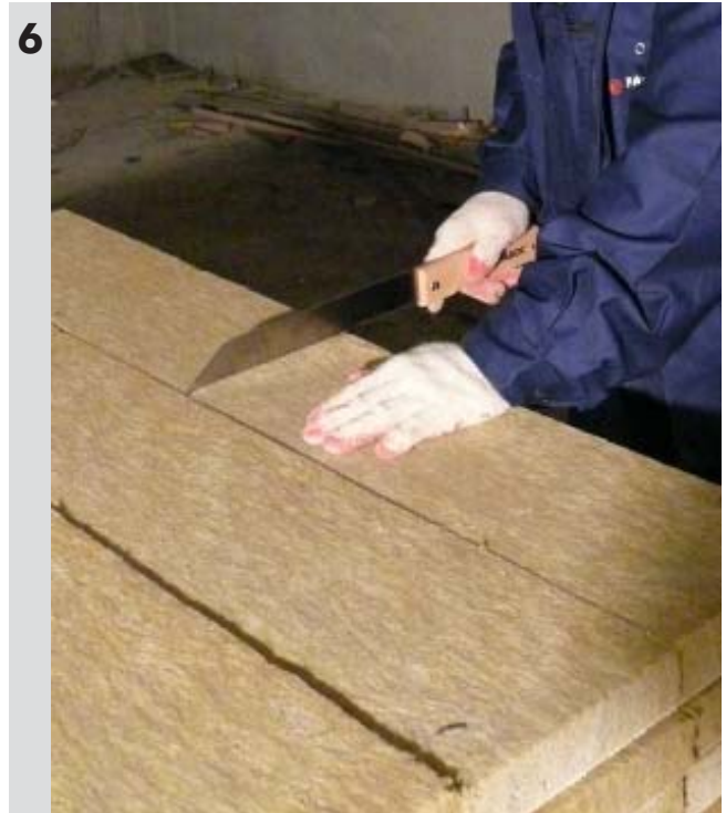
Cięcie płyt do wymiarów
