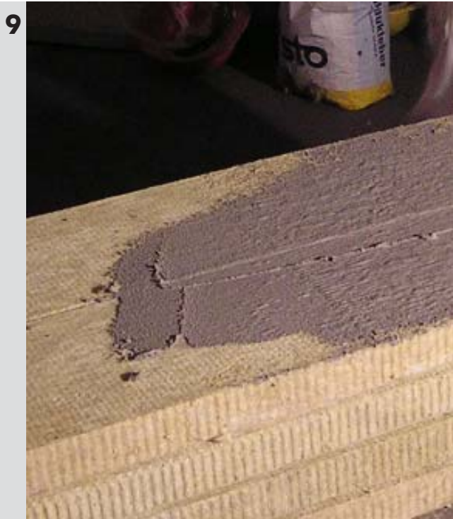
Rozprowadzenie wstępnej warstwy gruntującej
