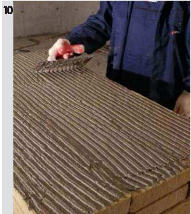
Naniesienie masy klejowej grzebieniem na zagruntowany wcześniej podkład
