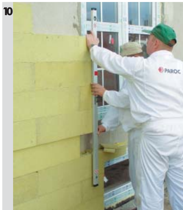
Kontrola pionu i poziomu ułożonych płyt
