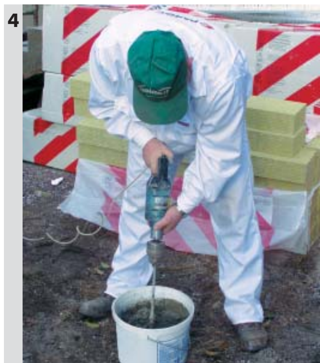
Przygotowanie zaprawy klejowej zgodnie z zaleceniami producenta
