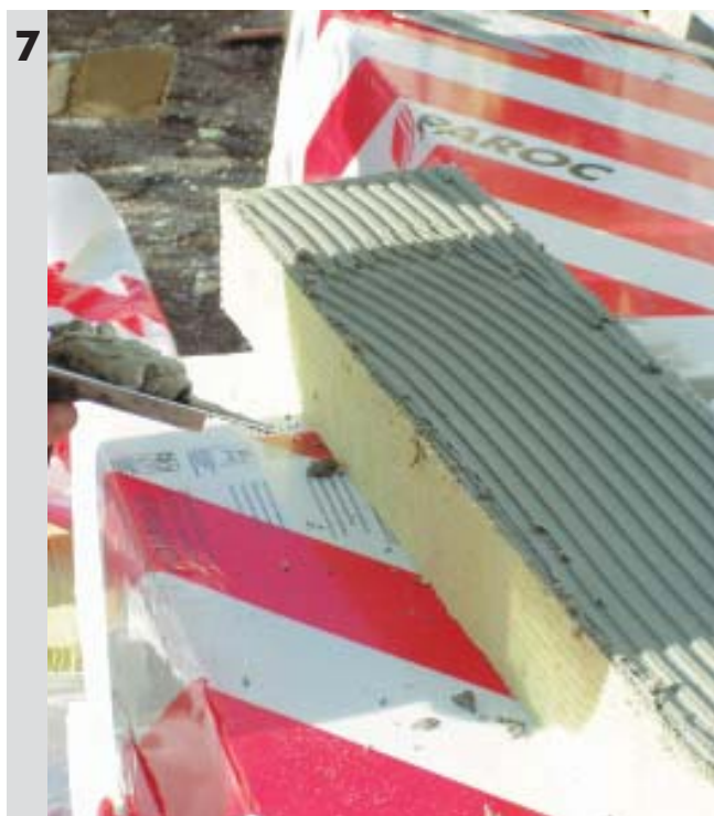
Nakładanie zaprawy na płytę - na całej powierzchni - za pomocą pacy zębatej
