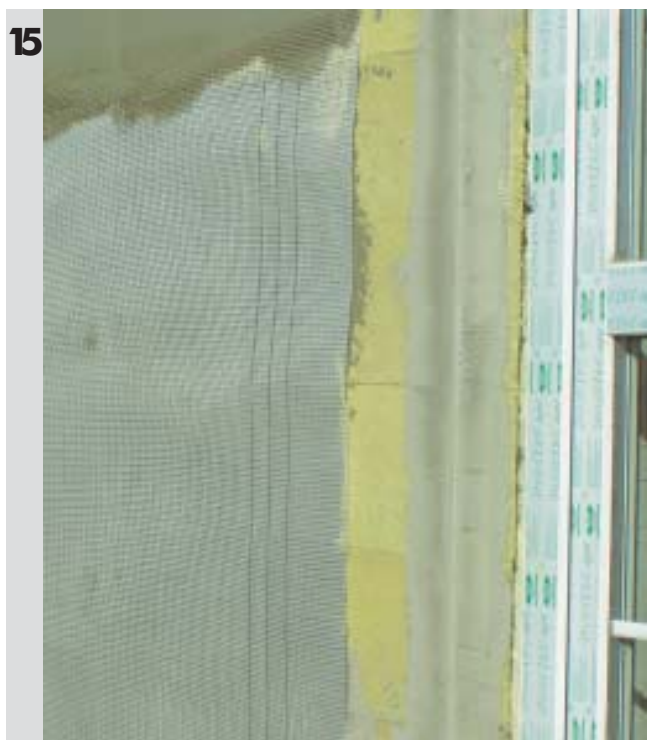
Zatopienie siatki z włókna szklanego - zakład co najmniej 10cm
