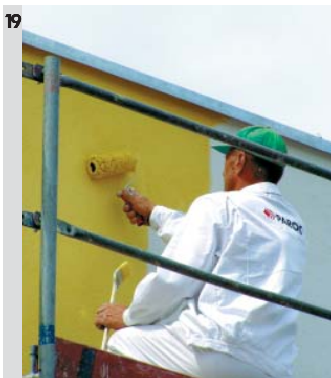
Malowanie wyschniętego tynku
