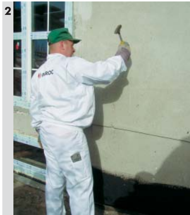
Sprawdzenie jakości i nośności podłoża (tynki odparzone należy skuć, a ubytki wyrównać zaprawą)
