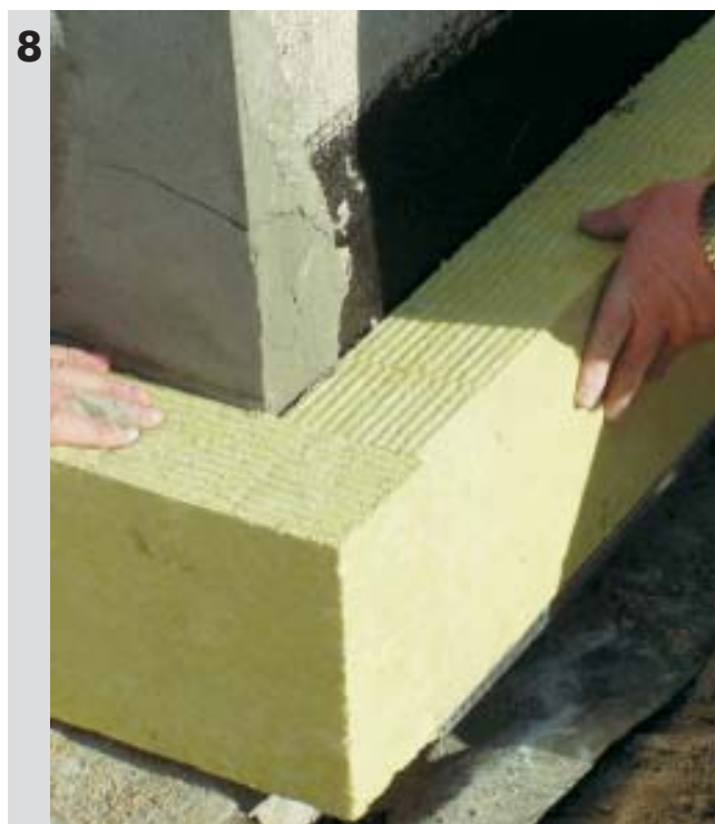
Przykładanie płyty do ściany - kolejne płyty przyłożyć kilka centymetrów od poprzedniej, docisnąć i dosunąć do poprzedniej
