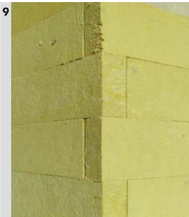
Płyty układać mijankowo
