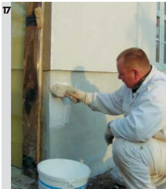
Gruntowanie powierzchni - jeżeli jest taki zapis w AT systemie
