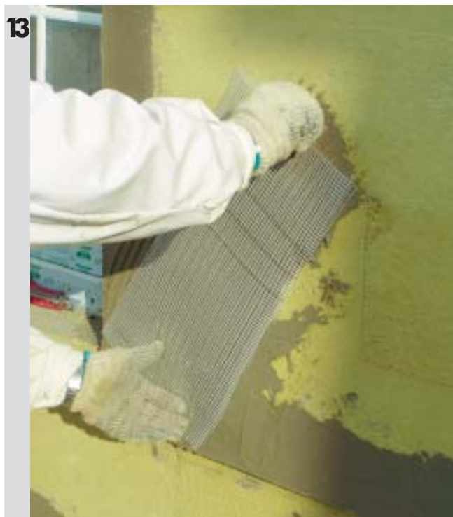
Dodatkowe zatopienie wzmacniających pasów siatki we wszystkich narożach otworów drzwiowych i okiennych
