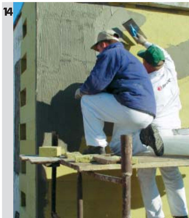
Naniesienie zaprawy na płyty z wełny
