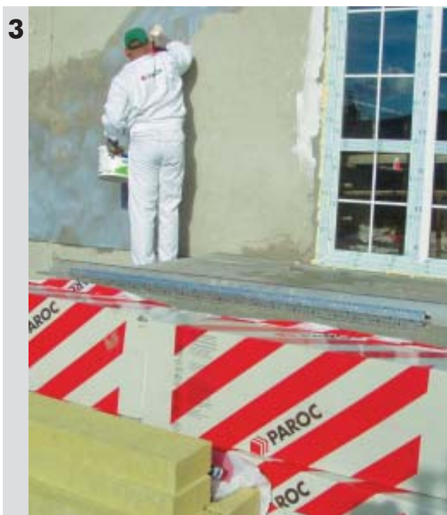
Podłoża o dużej nasiąkliwości należy zagruntować (patrz AT systemu)
