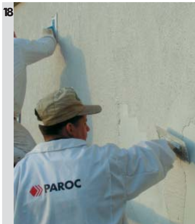
Nakładanie i zacieranie tynku cienkowarstwowego
