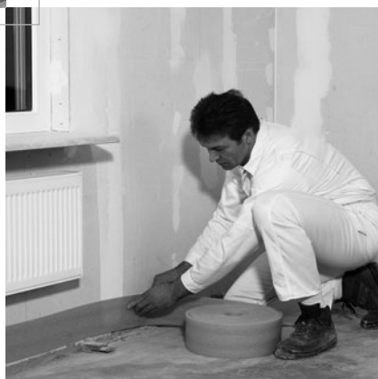
Samoprzylepna taśma do krawędzi (min. wysokość = wysokość podłogi elementu podłogi podniesionej + posadzka)
