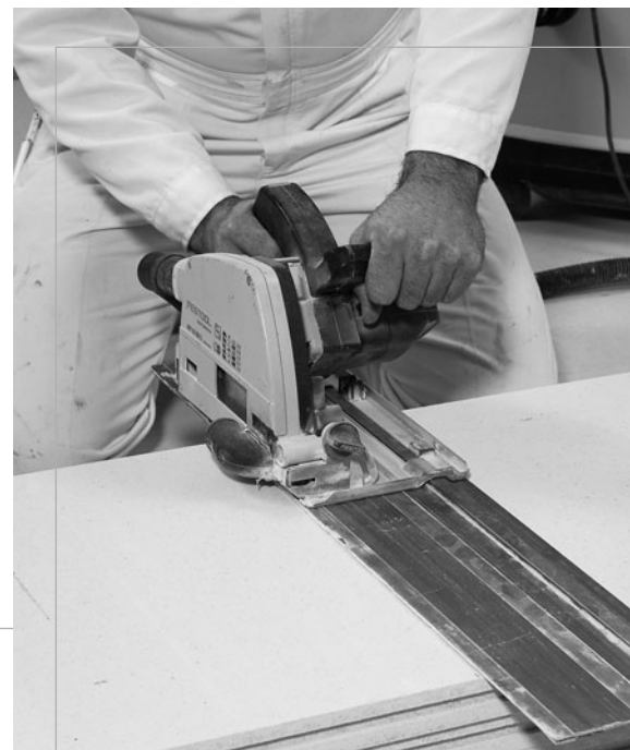
Cięcie przy użyciu piły z tarczą hartowaną i urządzeniem odsysającym
