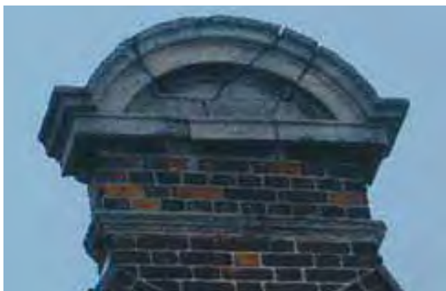
Wpływ działania czynników atmosferycznych na niezabezpieczone, betonowe zakończenia murów.
