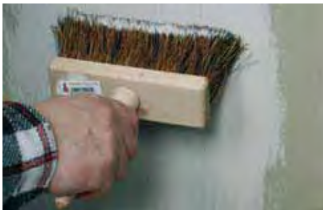
Nanoszenie mineralnych izolacji szlamowych.
