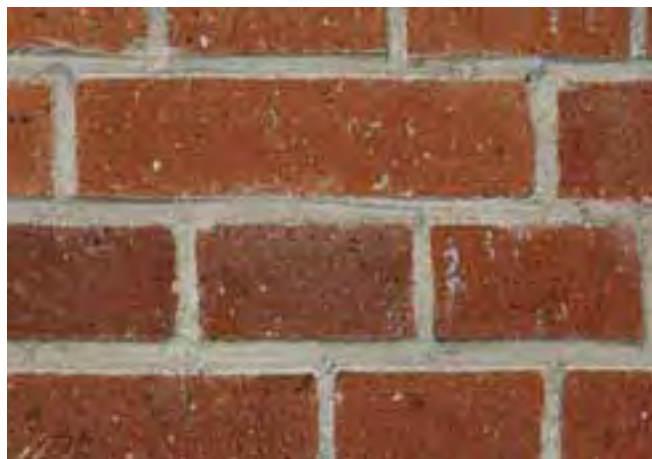
Mur po renowacji.
