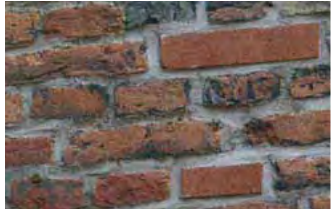
Wymienione cegły w murze licowym.
