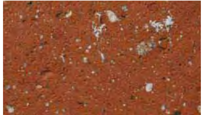
Powierzchnia cegły po czyszczeniu mechanicznym.
