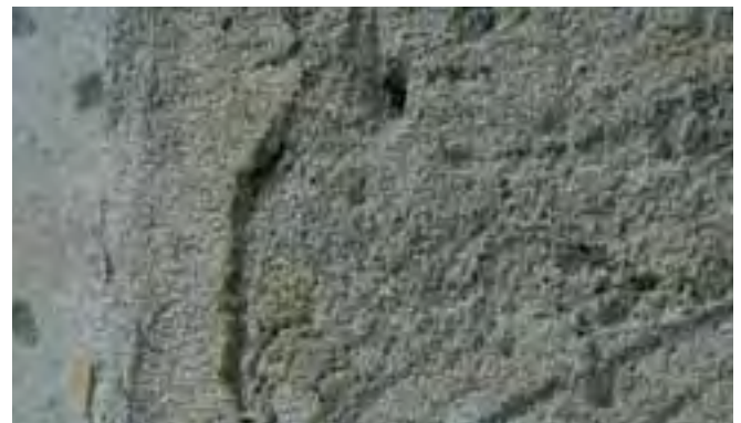
Powierzchnia tynku po czyszczeniu myjką wysokociśnieniową.
