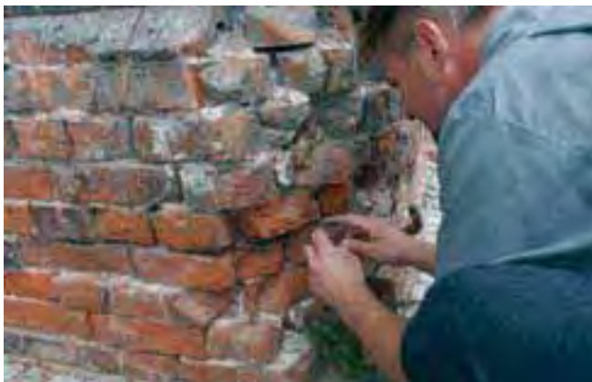
Analiza stanu technicznego muru.
