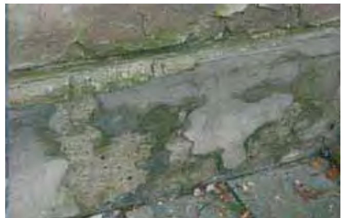
Próba naprawy powierzchni tynku wapiennego zaprawami cementowymi.
