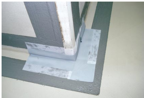
Rys. 8 Sposób wklejenia taśmy uszczelniającej ALPOL na połączeniu podłoża ze ścianą.
