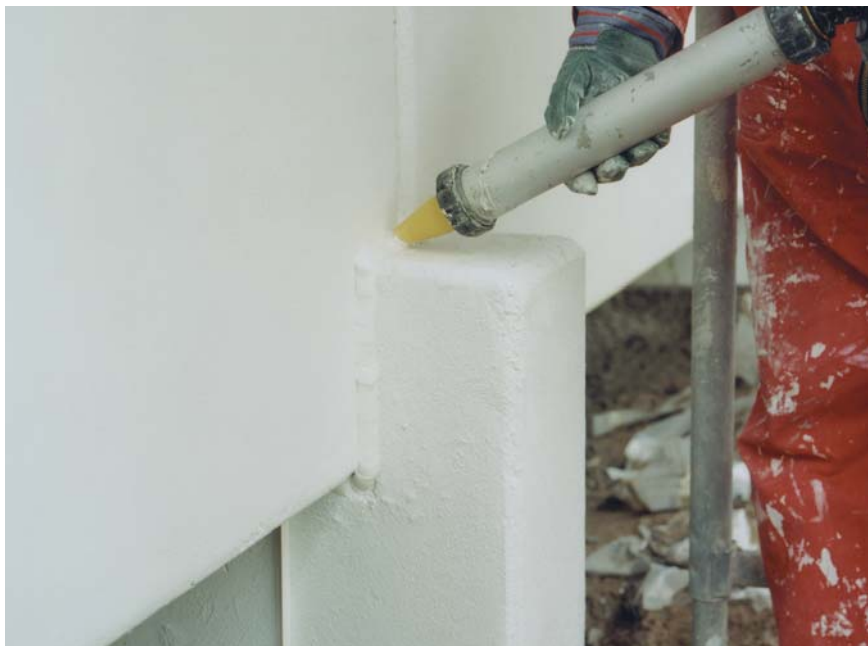
Zamykanie spoiny łączącej i szczeliny dylatacyjnej za pomocą PCI Elritan® 100
