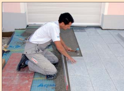
Wyklejanie płyt z ociosanego kamienia naturalnego na macie drenażowej za pomocą PCI Pavifix® DM.
