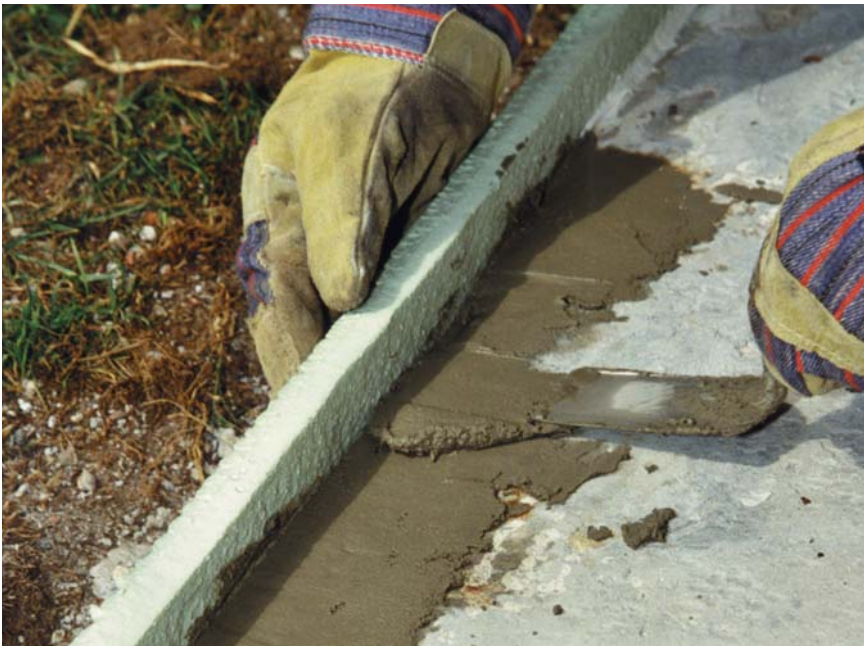
Dosztukowywanie odłupanej krawędzi tarasu za pomocą PCI Repafix®
