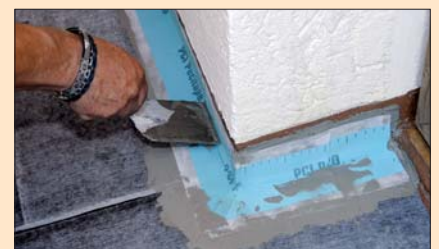
Przyklejanie taśm i narożników uszczelniających za pomocą PCI Seccoral® 1K/2K.
