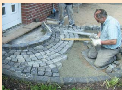
Układanie małej kostki brukowej na zaprawie PCI Pavifix® DM.
