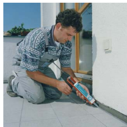
Elastyczne zamykanie połączenia między podłogą a ścianą samoprzyczepnym PCI Silcoferm® S
