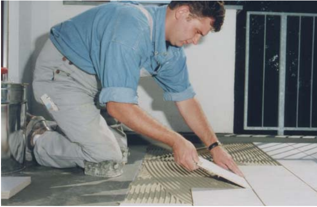
Układanie płyt ceramicznych bez pustek powietrznych za pomocą PCI Nanoflott®
