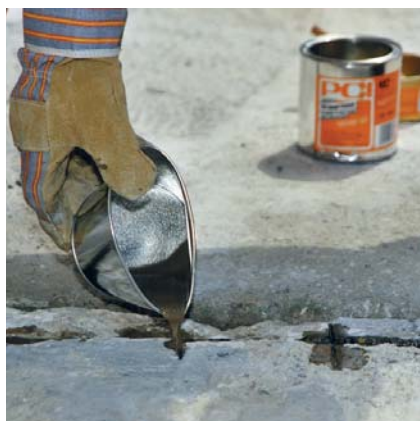
Wytrzymałościowe zamykanie rys przez zalanie preparatem PCI Apogel® F
