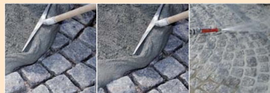
Spoinowanie metodą szlamowania.
