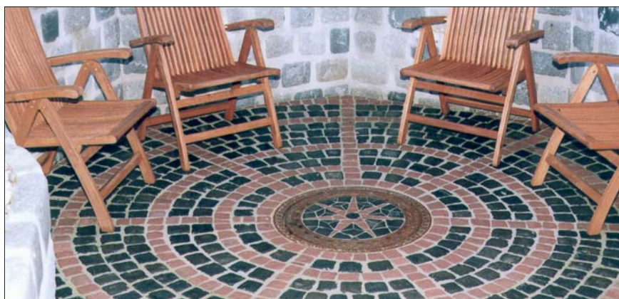
Zaprawy PCI Pavifix® 1K/PU nadają się do spoinowania kostki brukowej z kamienia naturalnego - mozaikowej, średniej i dużej.
