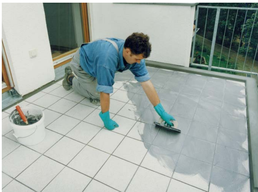
Spoinowanie okładziny ceramicznej za pomocą PCI Flexfug
