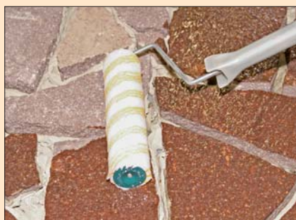
Preparat PCI Pavifix® V zastosowany przed spoinowaniem ułatwia czyszczenie okładzin po stwardnieniu spoiny.
