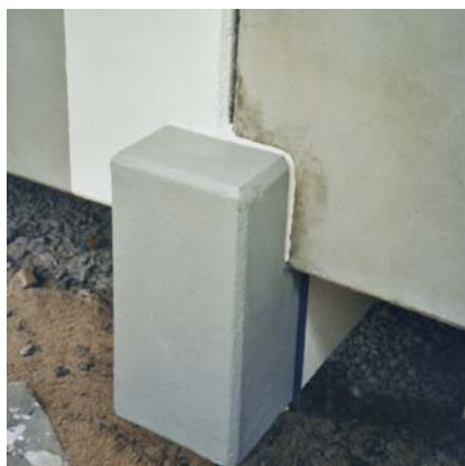
Powierzchnia betonowa wyszpachlowana wygładzająco za pomocą PCI Polycrret® 5
