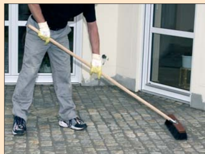
Wprowadziwszy zaprawę w szczeliny spoinowe starannie usuwamy jej resztki średnio twardą miotłą.
