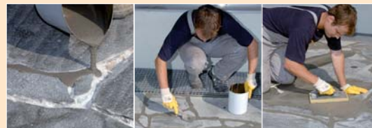
Spoinowanie metodą zalewania.
