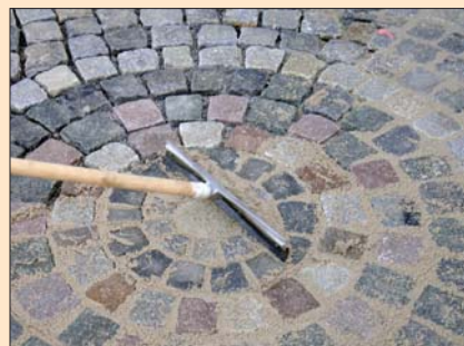
PCI Pavifix® 1K/PU daje się za pomocą pacy gumowej łatwo wprowadzać w szczeliny spoinowe i zagęszczać.
