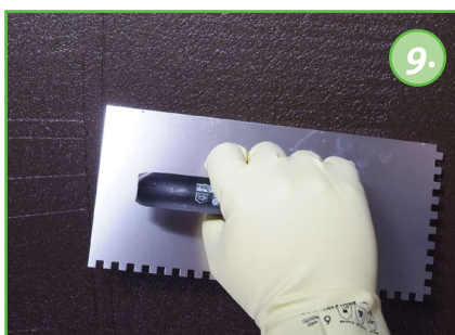
9. Nakładanie drugiej warstwy KÖSTER Bikuthan 2K
