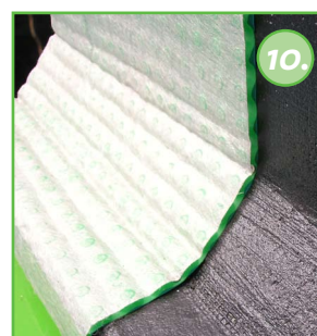
10. Ochrona izolacji za pomocą folii ochronno drenażowej KÖSTER SD
