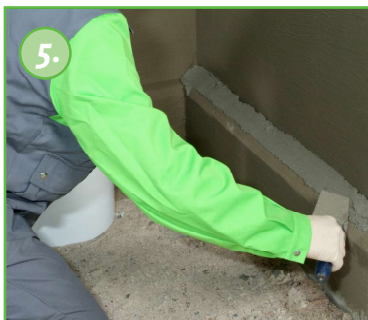
5. Faseta uszczelniająca z zaprawy KÖSTER Sperrmörtel
