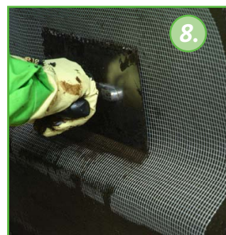
10. Ochrona izolacji za pomocą folii ochronno drenażowej KÖSTER SD
