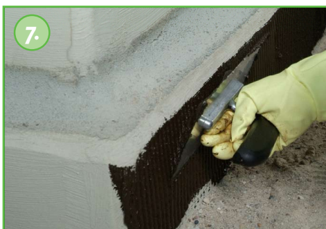
9. Nakładanie drugiej warstwy KÖSTER Bikuthan 2K
