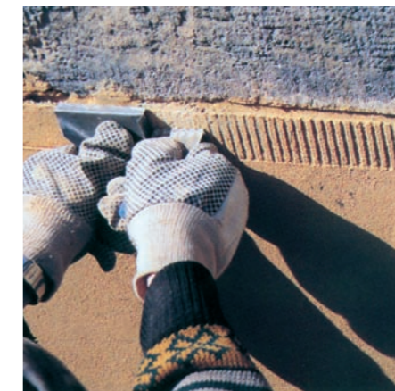
Restauriermörtel SK również jako warstwa szpachlowa do naprawy zniszczonych powierzchni.
