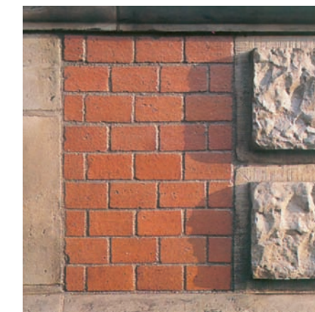
6. Elewacja po konserwacji
