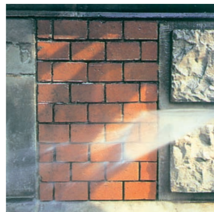
3. Czyszczenie elewacji - drugi zabieg
