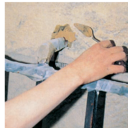
Restauriermörtel barwiona w masie zaprawa renowacyjna do uzupełniania ubytków cegły i kamienia.
