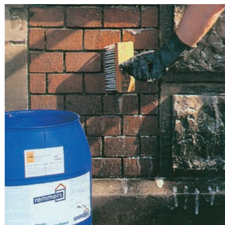
2. Czyszczenie elewacji - pierwszy zabieg
