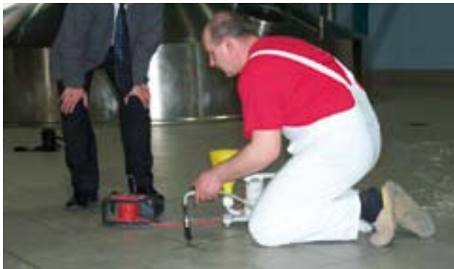
Wstrzykiwanie za pomocą techniki iniekcyjnej (15 barów).
