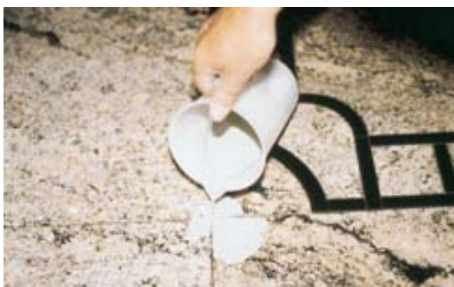
Wypełnianie przez otwartą fugę.
