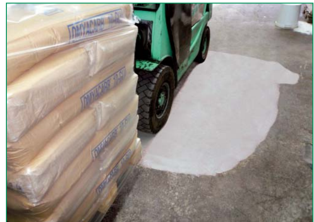
Powłoka wykonana masą szpachlową HADAPLAN® BM 55 HSP już po ok. 90 minutach twardnienia może być poddawana wysokim obciążeniom – tutaj np. jeździ po niej wózek widłowy o nacisku 1000 kg/koło
