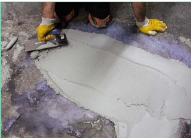
HADAPLAN® BM 55 HSP wyrównać, zagęścić i wygładzić pacą do wygładzania
