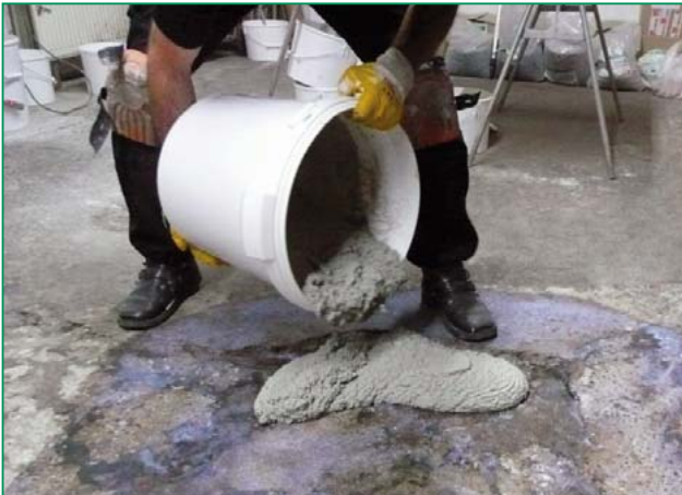
HADAPLAN® BM 55 HSP rozrabia się z wodą do uzyskania jednnorodnej masy
