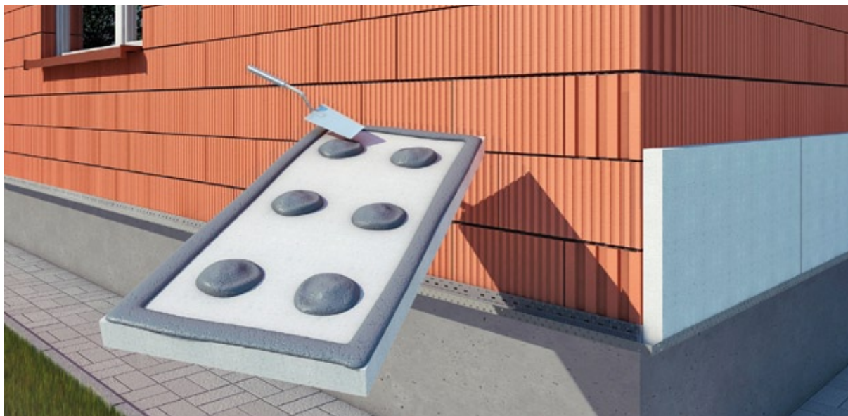
Rys. 7a. Nakładanie zaprawy klejącej na powierzchnię płyty styropianowej
