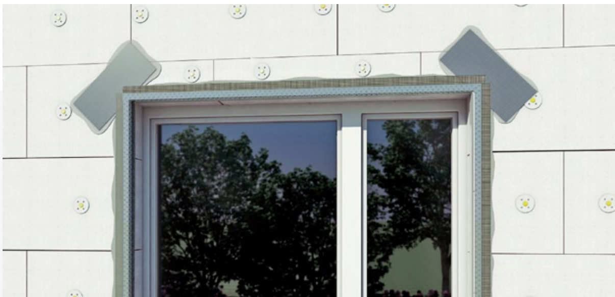
Rys. 20. Wzmacnianie wypustów przy narożnikach
