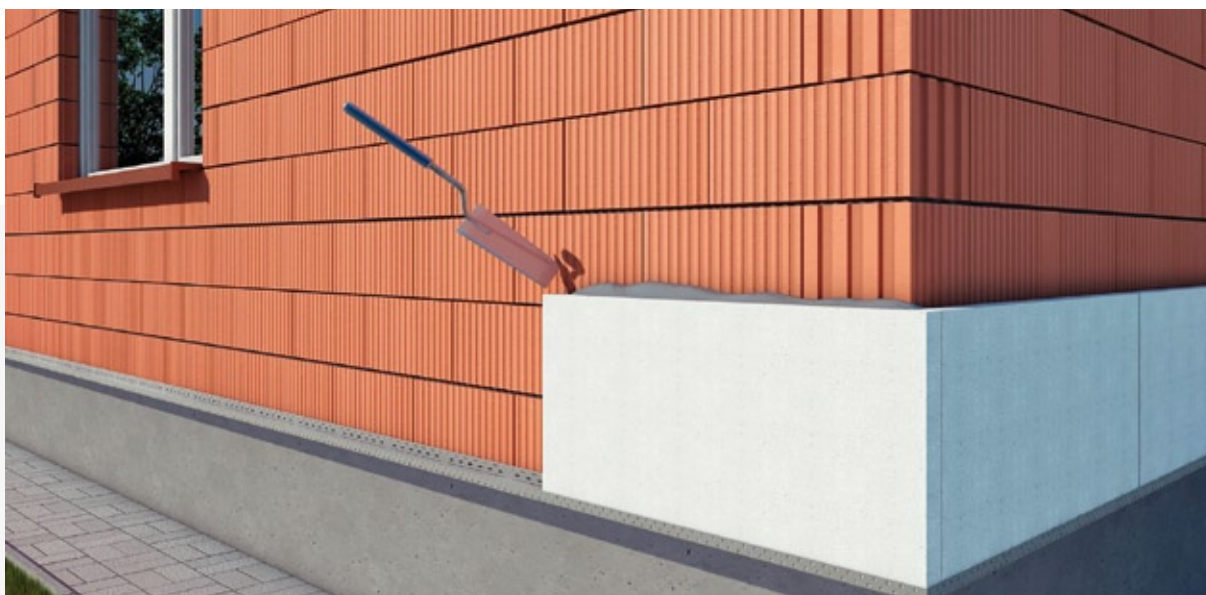
Rys. 9. Usuwanie nadmiaru zaprawy klejącej
