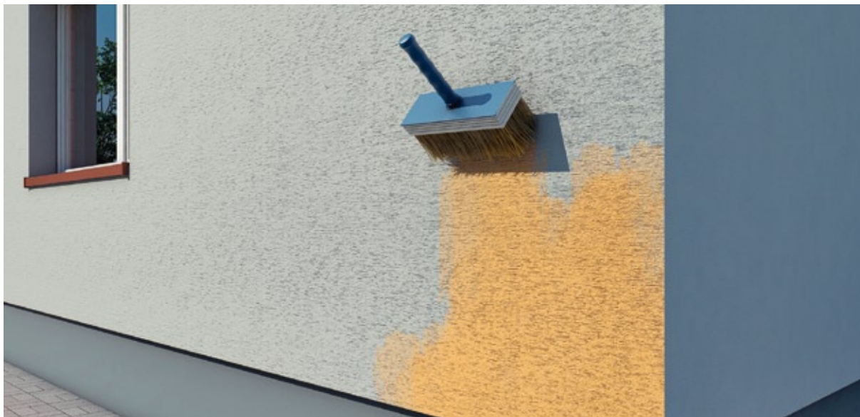
Rys. 30. Malowanie tynku mineralnego
