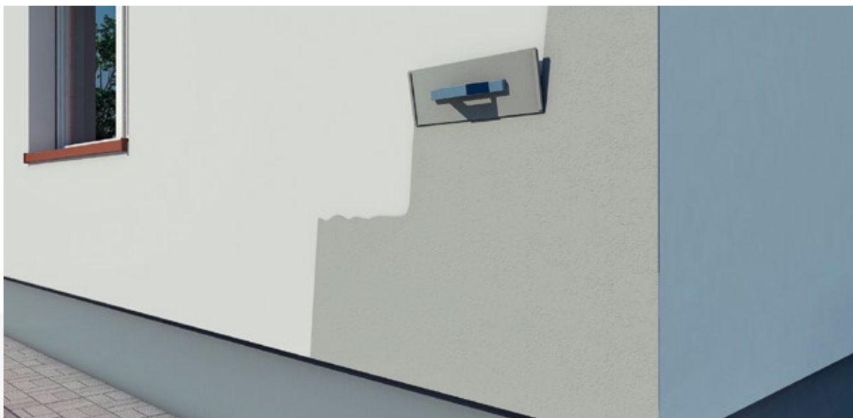
Rys. 28 a). Ręczne nakładanie tynku (tynk mineralny)
