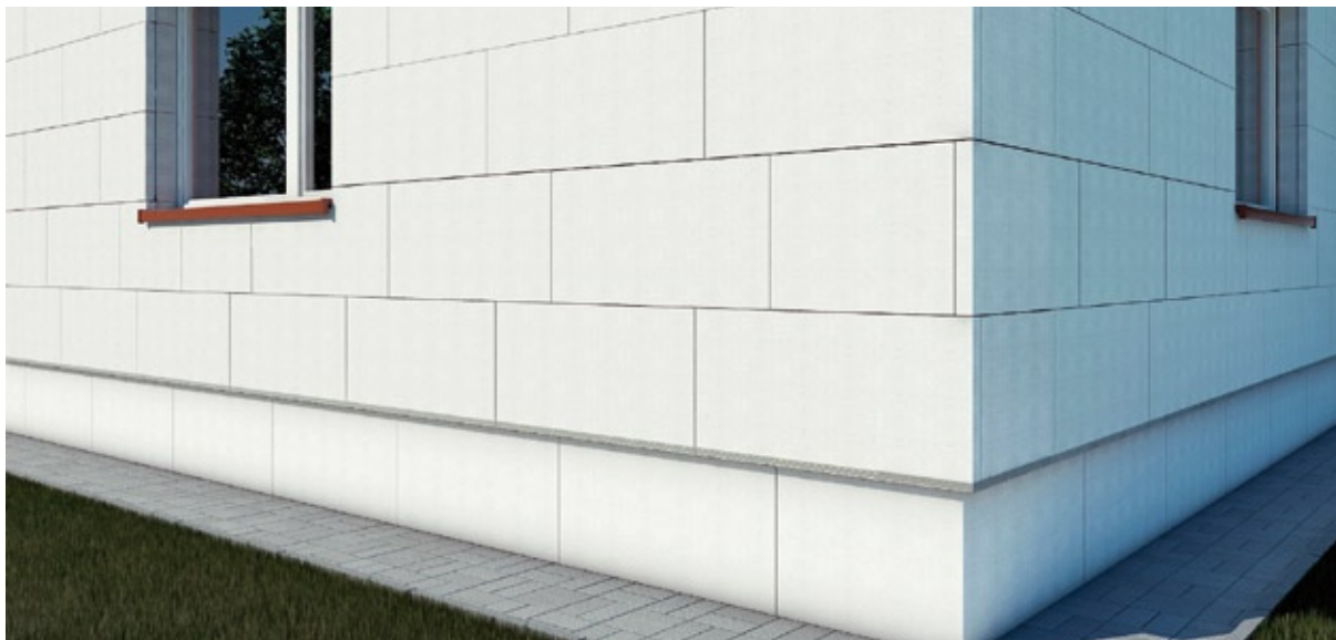
Rys. 15. Prawdłowo zamontowana warstwa termoizolacyjna
