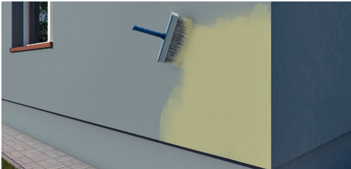
Rys. 26. Nakładanie podkładu gruntującego
