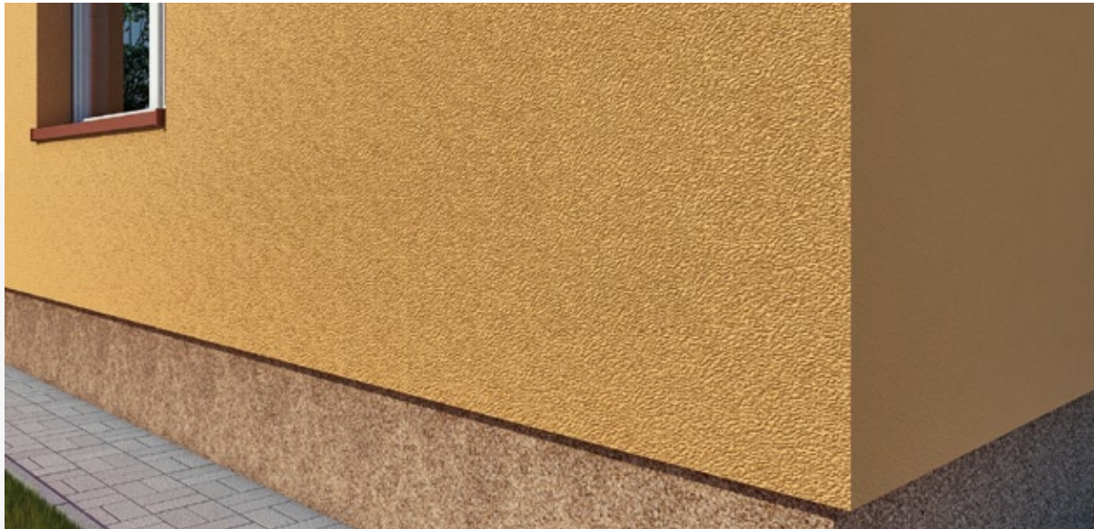
Rys. 31. Prawidłowo wykonana wyprawa tynkarska
