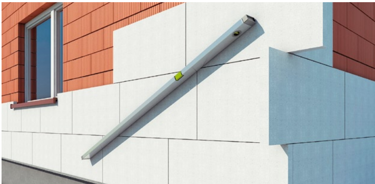
Rys. 10. Kontrola ustawienia płyt poziomą
