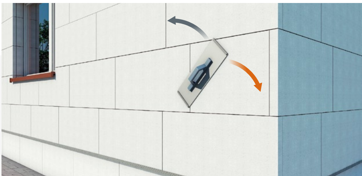
Rys. 14. Szlifowanie powierzchni płyt styropianowych
