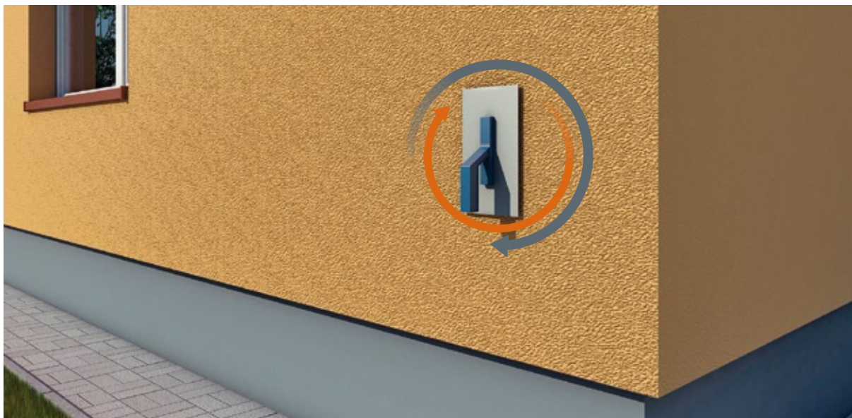
Rys. 28 d). Kierunek przesuwania pacy przy zacieraniu tynku o strukturze baranka
