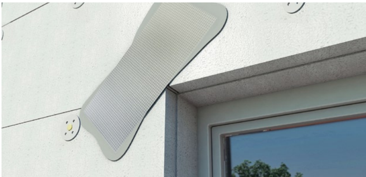
Rys. 19. Wzmacnianie paskami siatki naroży przy otworach elewacyjnych
