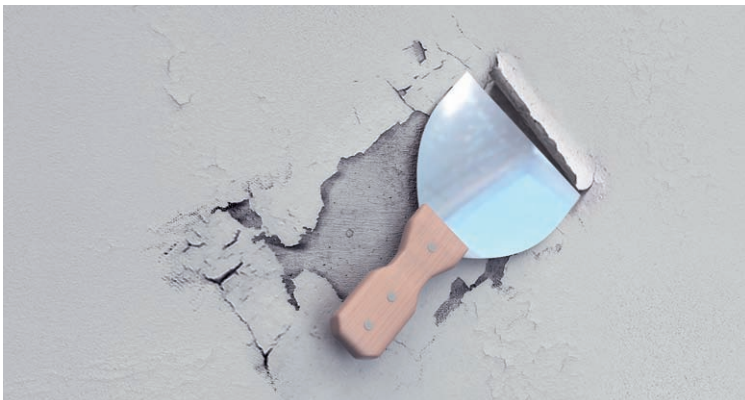
7. Usuwanie szpachelką starych powłok
