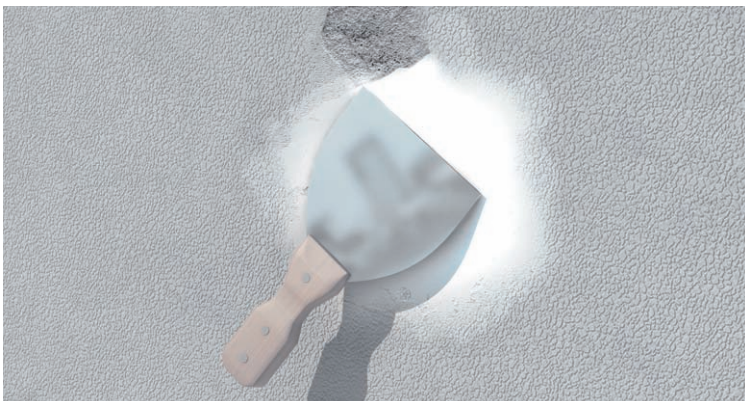
32. Szpachlowanie elewacji z użyciem ACRYL-PUTZ® FASADA
