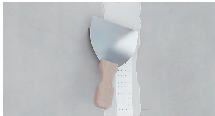
25. Nakładanie taśmy papierowej i dociskanie jej szpachelką
