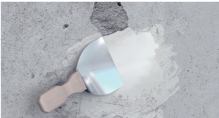
11. Szpachlowanie dużego ubytku
