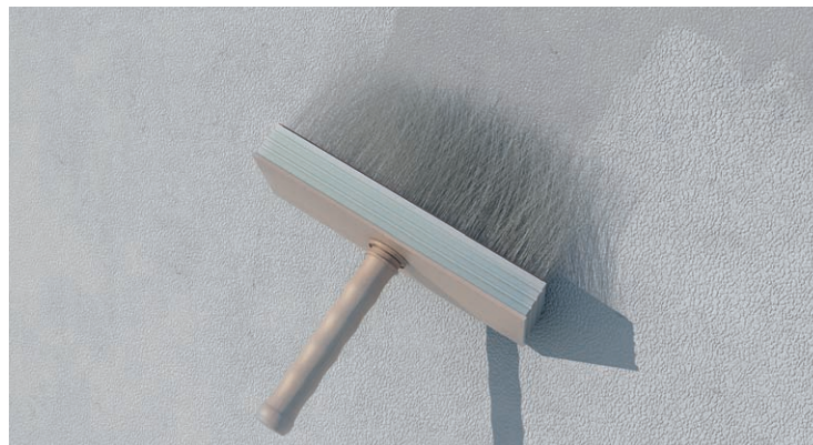
30. Gruntowanie elewacji przed szpachlowaniem
