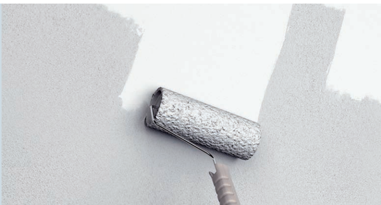
21. Malowanie ściany farbą podkładową Śnieżka GRUNT
