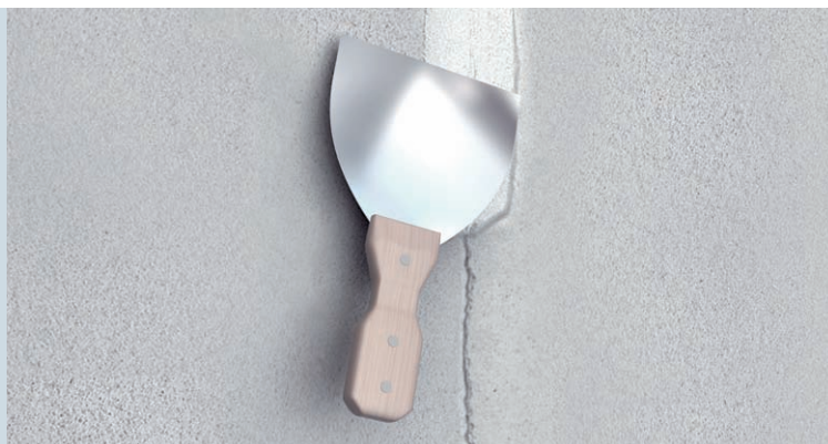
9. Nanoszenie ACRYL-PUTZ® FLEX na pęknięcie
