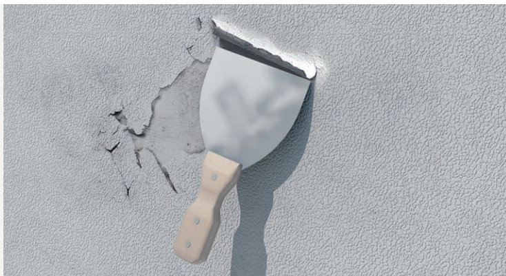
29. Usuwanie zanieczyszczeń z powierzchni fasady przy pomocy szpachelki
