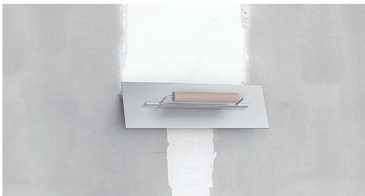
26. Nakładanie masy szpachlowej na zespolowane płyty
