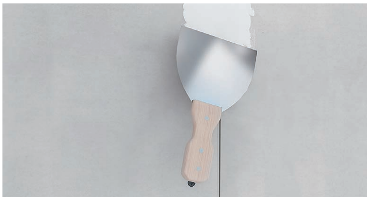
24. Nakładanie warstwy ACRYL-PUTZ® FINISZ na łączenie płyt
