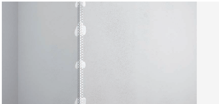
12. Montaż profilu aluminiowego do narożnika ściany
